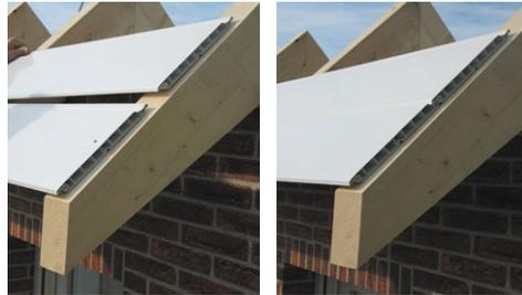
Folienbeschichtete Verkleidungsprofile müssen einen Dehnungsabstand von 15 mm zu den Außenkanten der Zusatzprofile haben.
